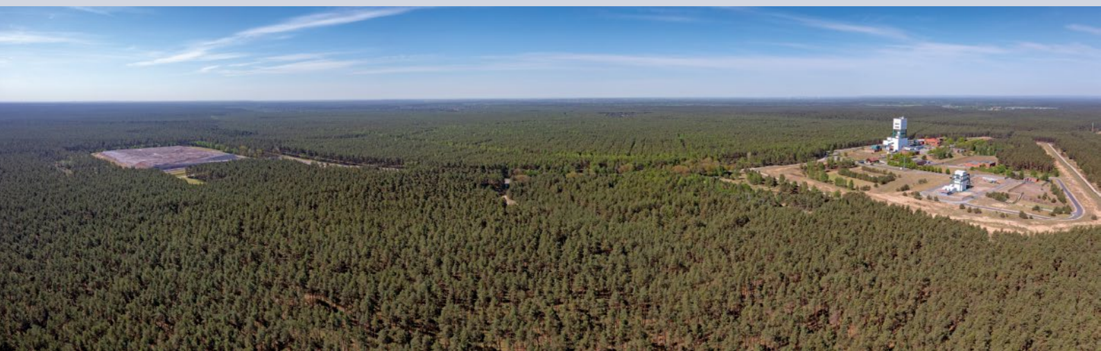
Bergwerk Gorleben mit Salzhalde
