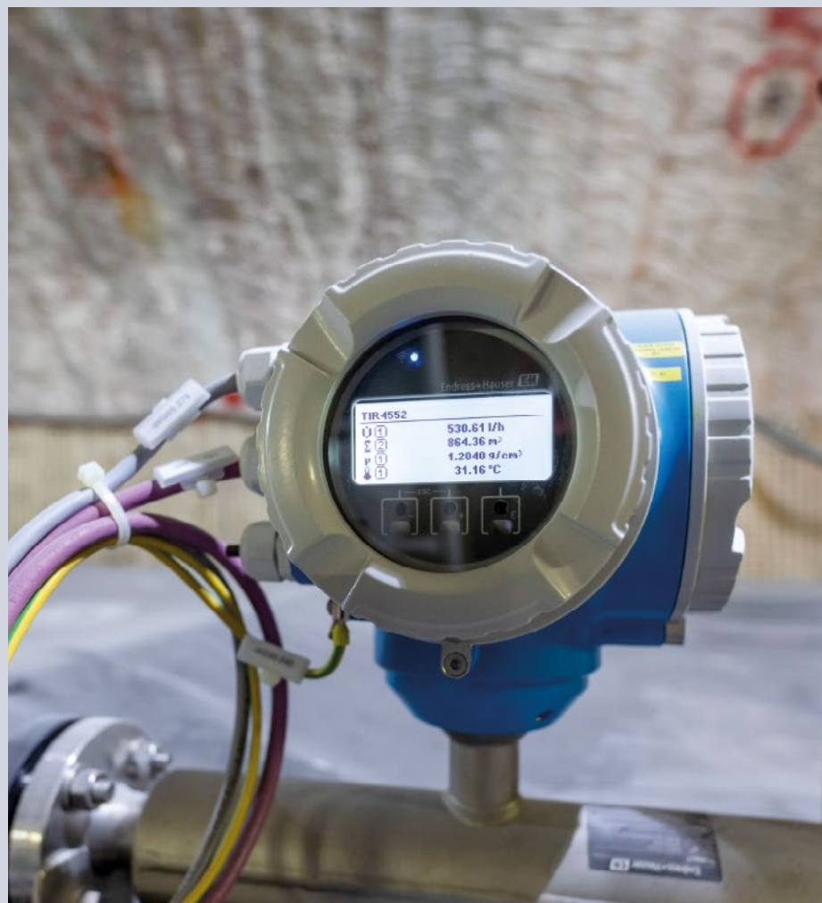
Schachtanlage Asse: neue Messeinrichtung für Durchflussmenge, Dichte und Temperatur an der Hauptfassungsstelle auf der 658-m-Sohle
