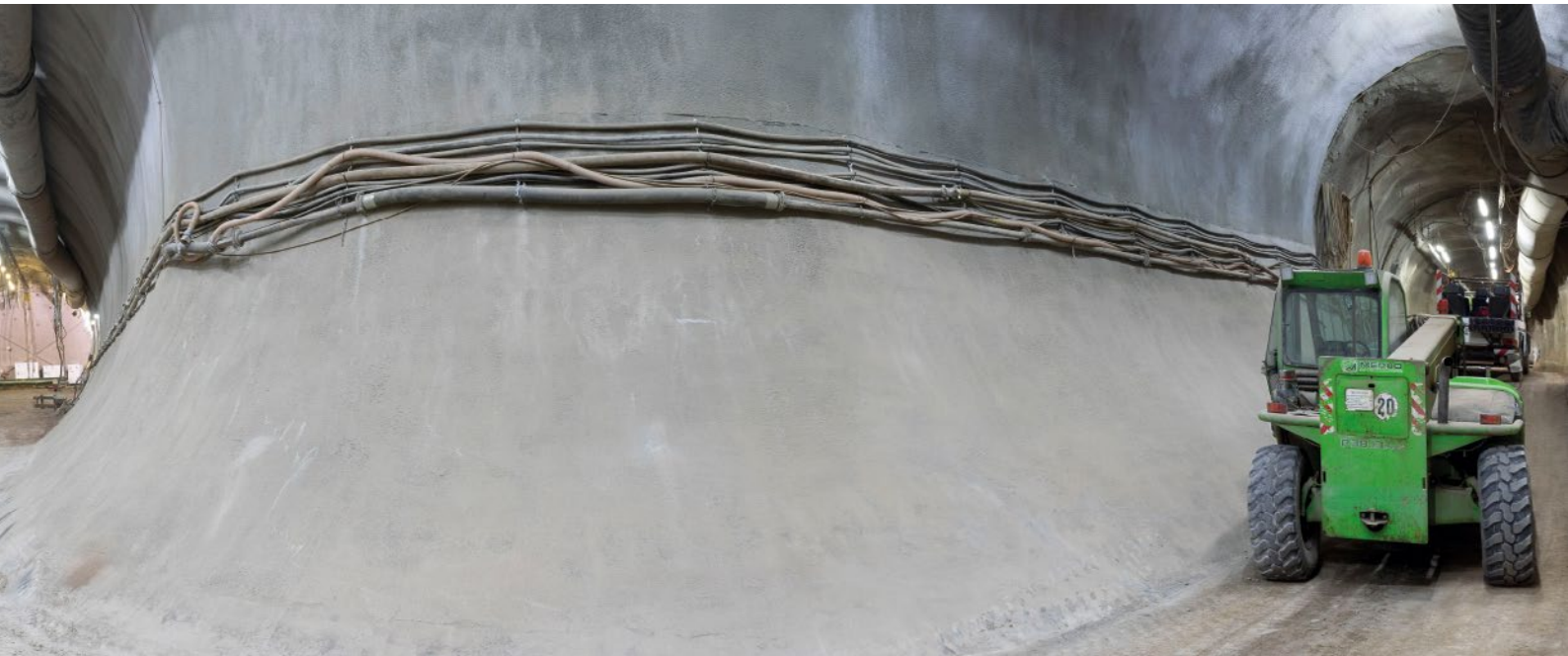
Schachtanlage Konrad: Streckenkreuz an der Vorbrecheranlage, 2. Sohle
